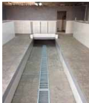
I vår var Ole og Roald Moi ned og fekk gjort ferdig støypearbeidet til det nye fjøset. Og slik såg det ut i fjøset då venne-gjengen kom ned for å montera mjøleanlegget – reint og fint.
