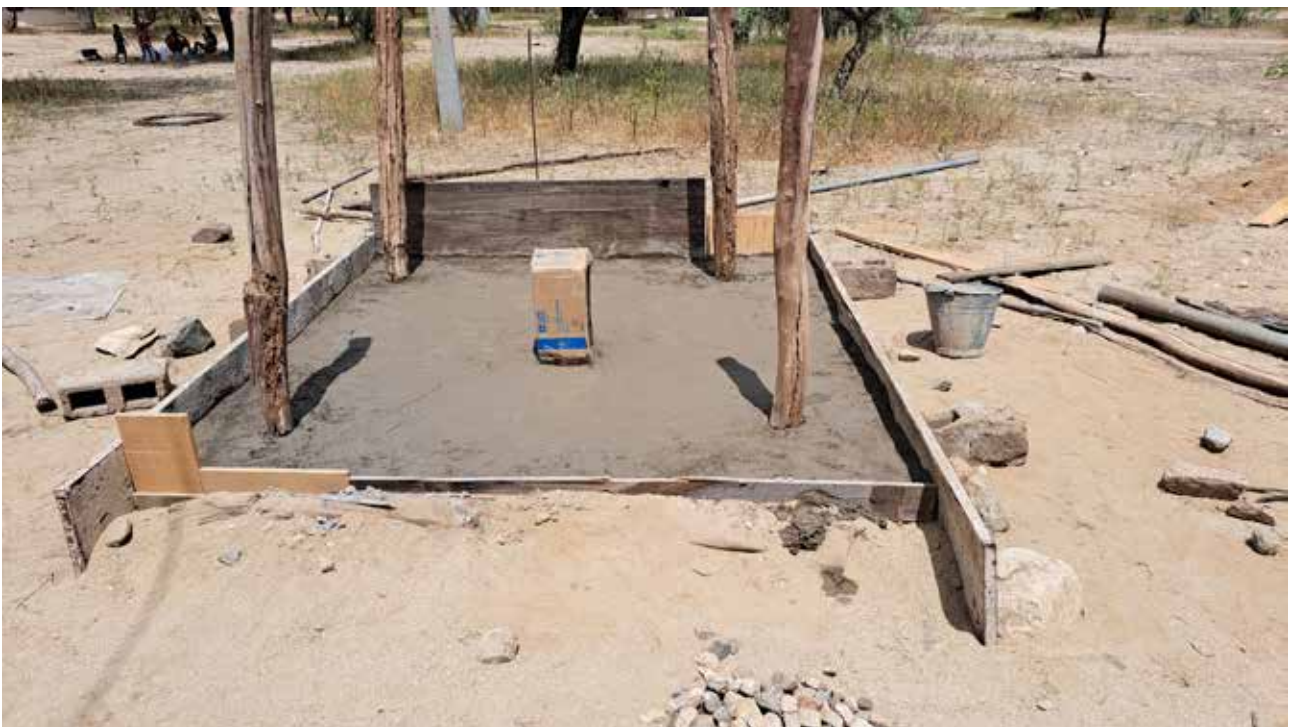
Støyping fundament for utedo
